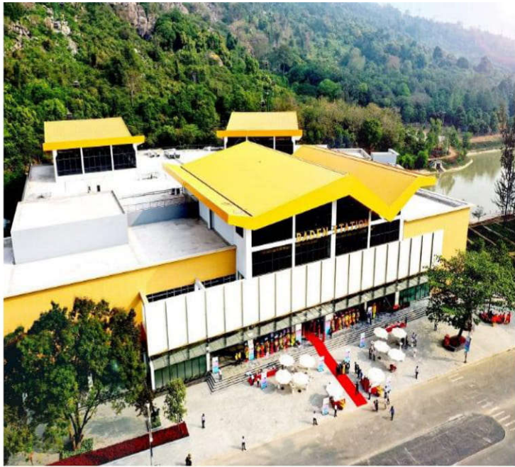
SUNGROUP – NÚI BÀ TÂY NINH ( THI CÔNG TRẠM 2500kA )
