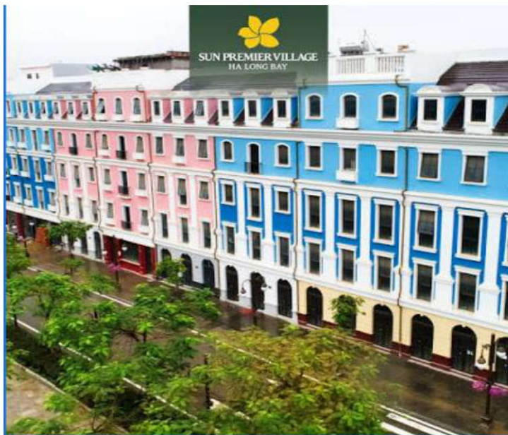
SUNGROUP – HẠ LONG BAY ( THI CÔNG 7 TRẠM HỢP BỘ RMU – MBA - MSB )
